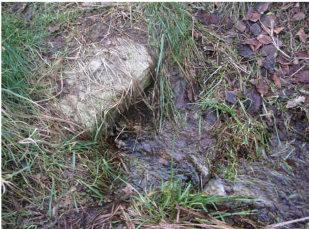
Esistono alcune problematiche che riguardano il sistema di drenaggio delle acque meteoriche, in particolare la mancanza di manutenzione e l'obsolescenza delle opere.
